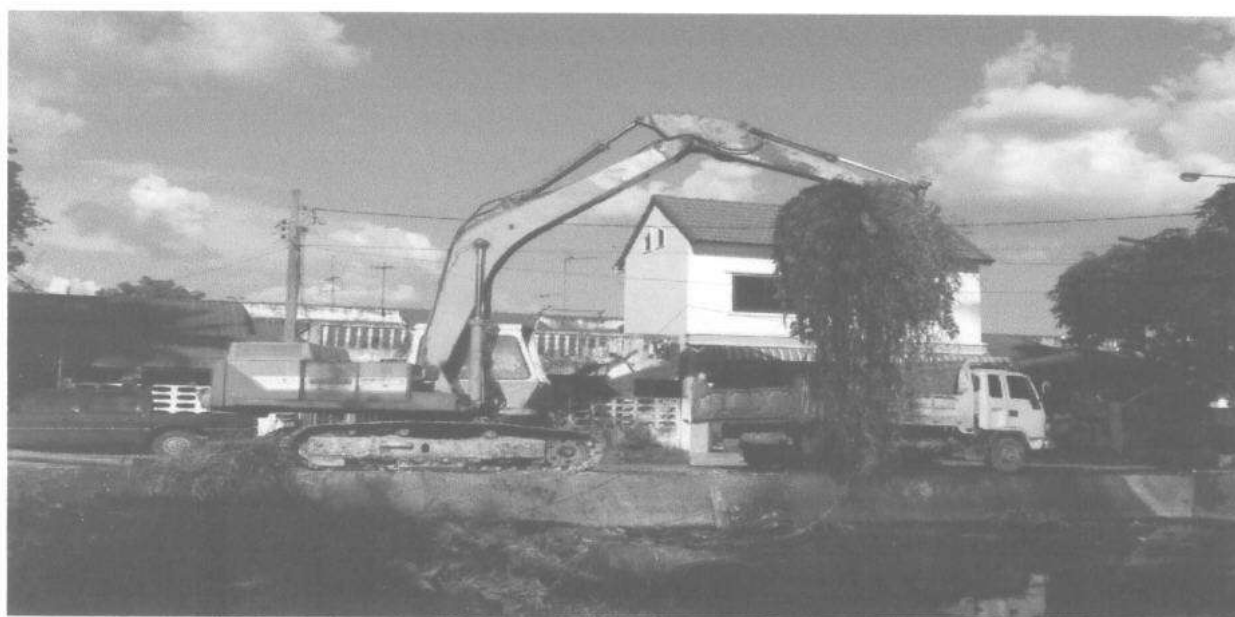
ภาพที่ 9 การขุดลอกบ่อบำบัดน้ำเสีย
