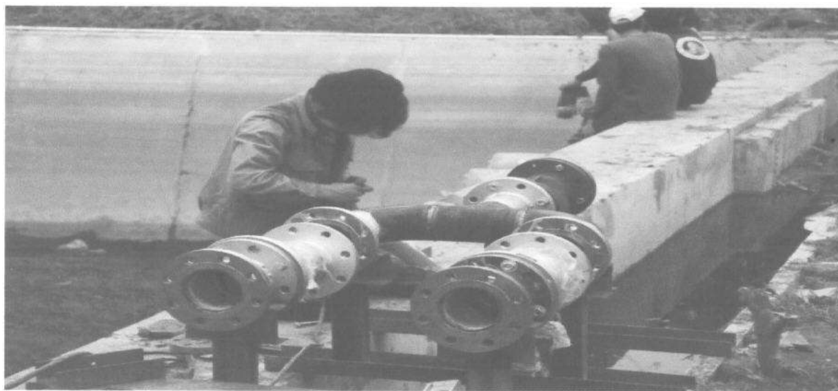
ภาพที่ 10 ปรับปรุงระบบบ่อน้ำบาดาลเสีย
