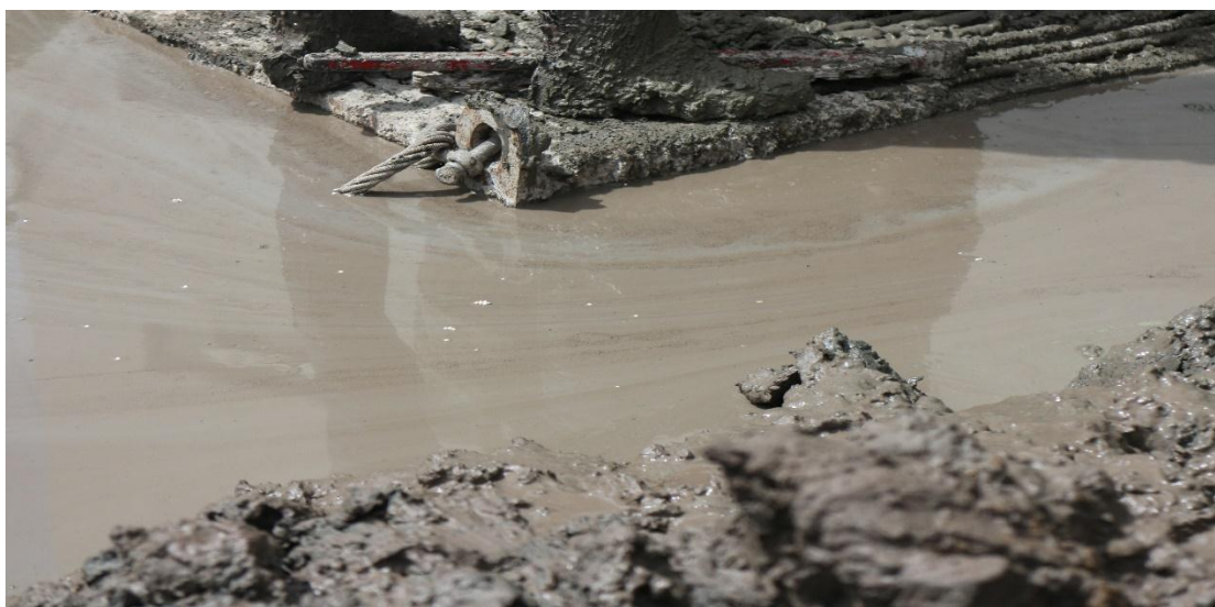
ภาพที่ 7 การสูบน้ำทำความสะอาดบริเวณหลุมเจาะ (กฤษฎา ภูมิ, 2559, โครงการสุขุมวิทซอย18)
