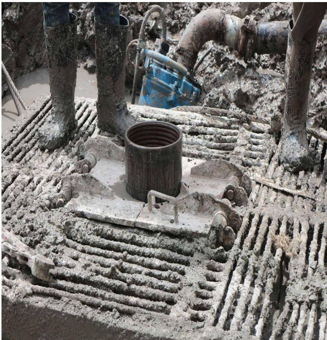
ภาพที่ 10 แสดงวิธีการสูบน้ำอัดสารเบนโทไนท์ (กฤษฎา ภูมิ, 2559, โครงการมหาวิทยาลัยหอการค้าไทย)
