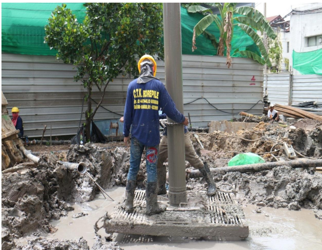
ภาพที่ 12 การติดตั้งท่อสำหรับเทคอนกรีต (กฤษฎา ภูมิ, 2559, โครงการสถานทูตญี่ปุ่น)
