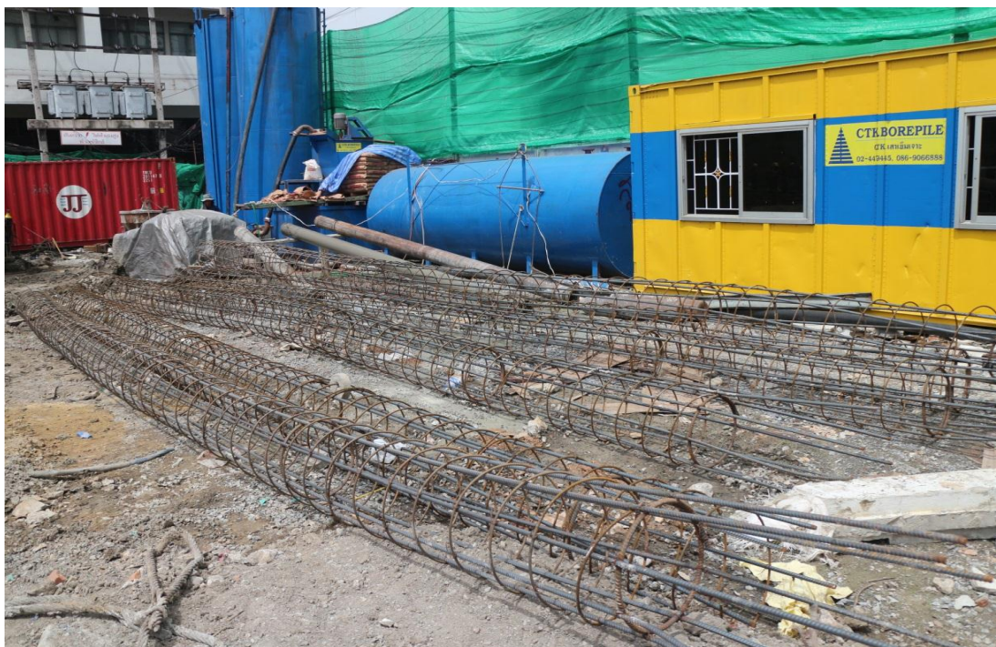
ภาพที่ 8 โครงเหล็กเสริม (กฤษฎา ภูมิ, โครงการสุขุมวิทซอย18, 2559)
