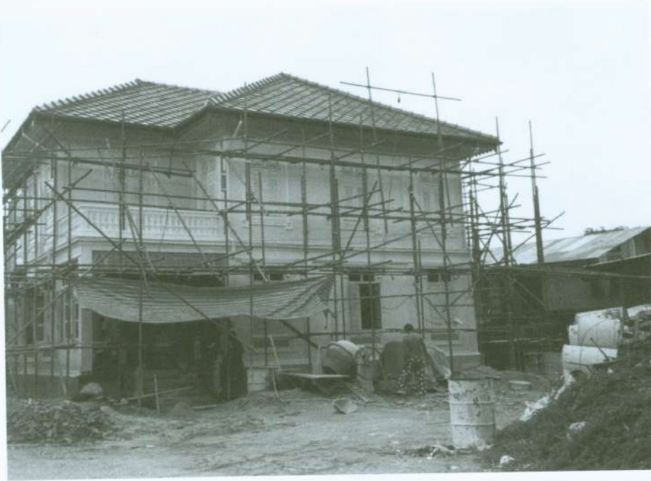
บ้านเอกะนาคระระหว่างการปรับปรุงซ่อมแซม
