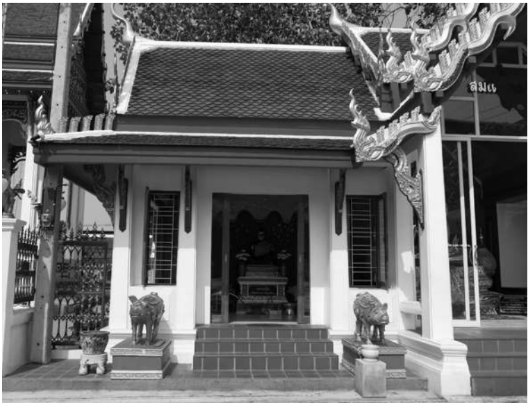
ศาลาหลวงปู่โตที่ทางวัดบูรณะใหม่ มีการสร้างรูปปั้นหมูเงินหมูทองที่ทางเข้าศาลาด้วย (ภาพ : ศูนย์ข้อมูลเล็ก-ประไพ วิริยะพันธุ์)
